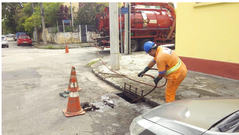
Execução dos serviços de limpeza em bueiro
