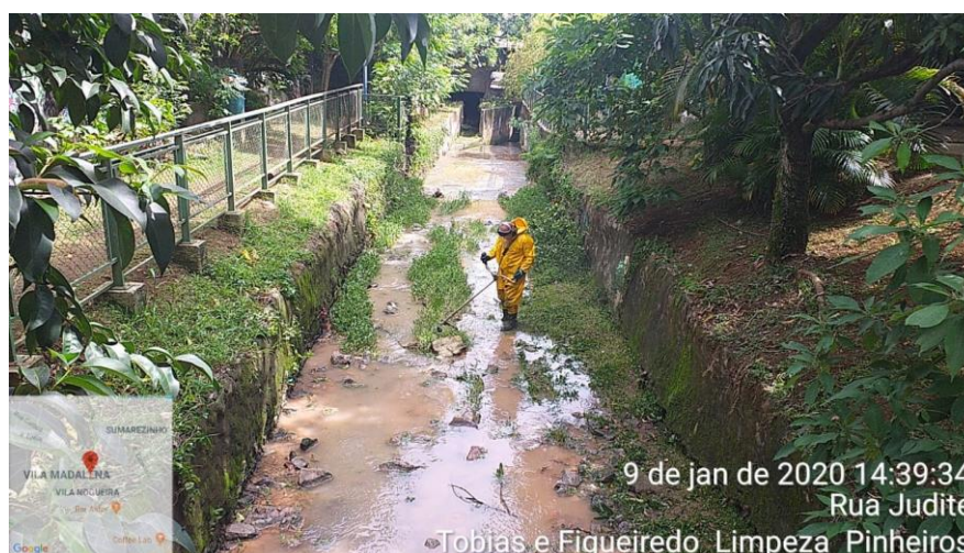
Limpeza de córrego
