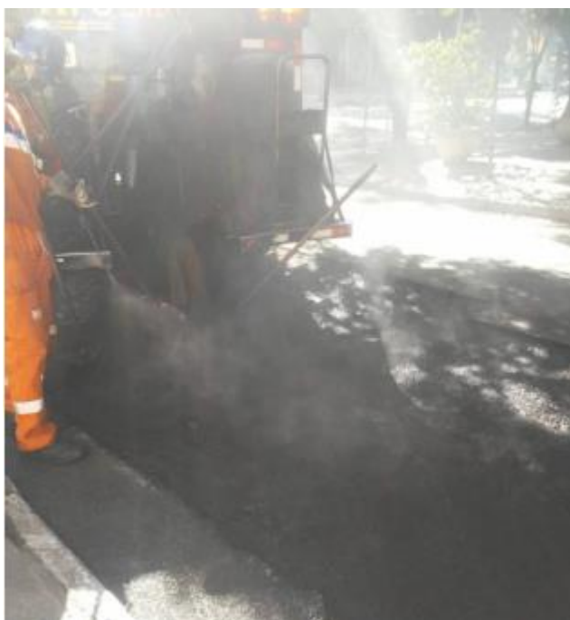
Foto 3 – Execução de pintura com emulsão asfáltica
