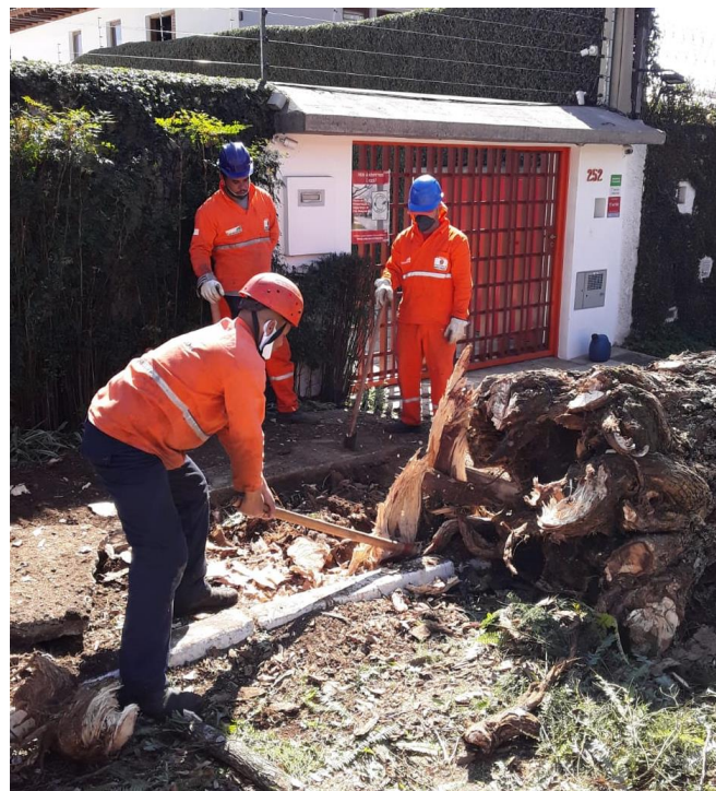
Remoção de árvore
