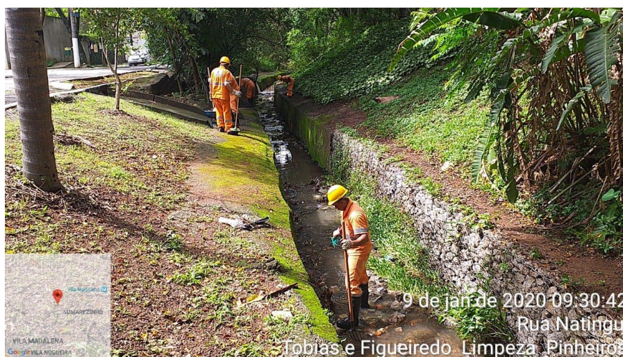
Limpeza de córrego
