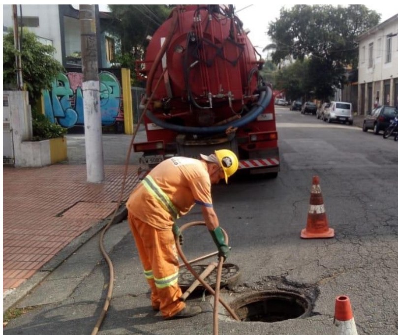
Execução de serviços de limpeza em PV
