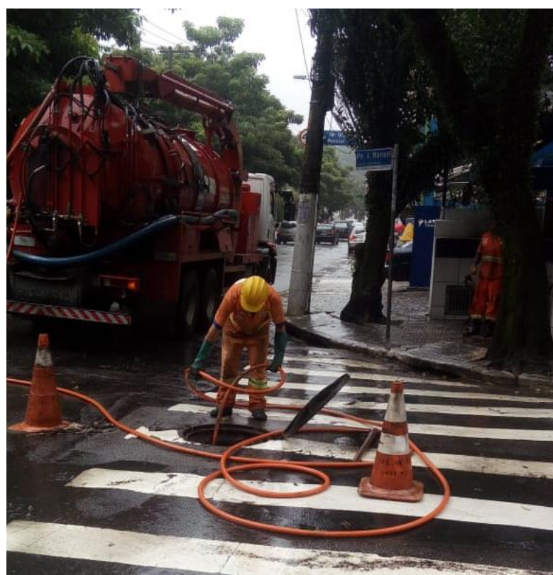
Execução de serviços de limpeza em PV
