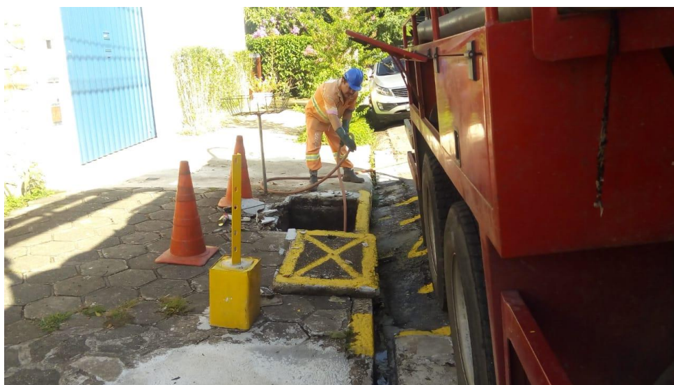
Execução dos serviços de limpeza em boca de lobo
