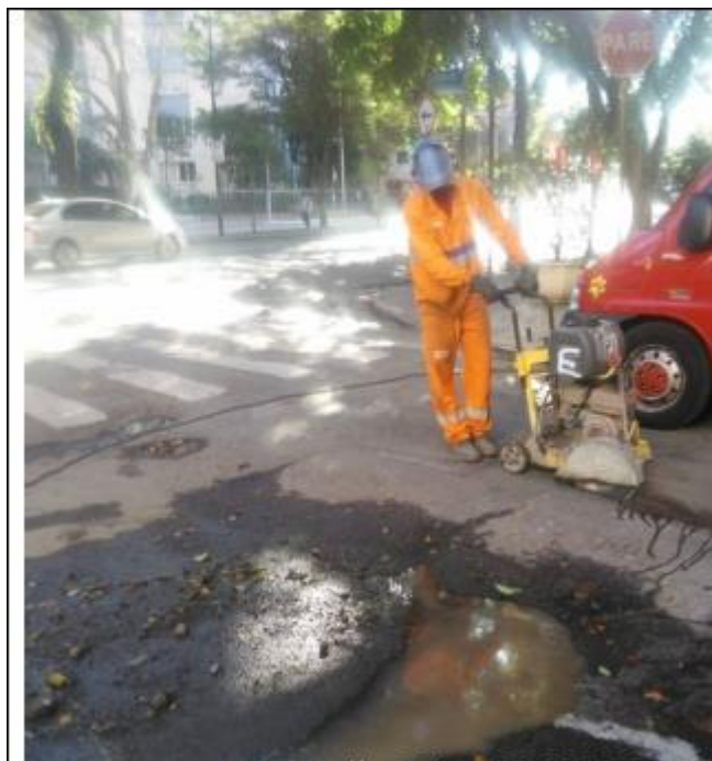
Foto 1- Reequadramento do buraco, primeiramente utilizando a serra diamantada e posteriormente, o martelete
