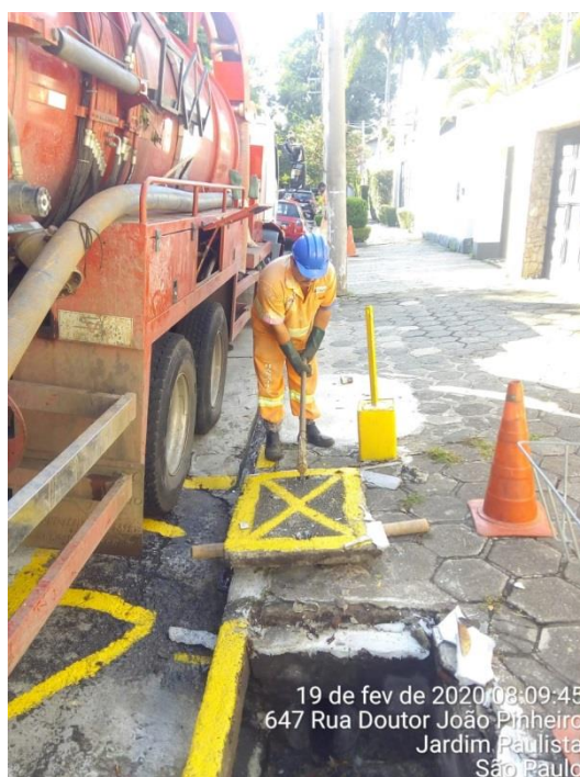
Abertura da Boca de Lobo
