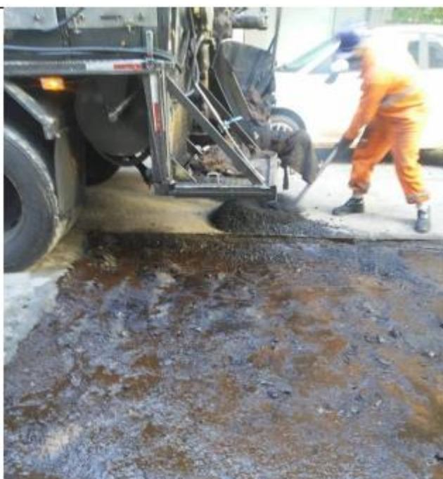
Foto 4 – Após a aplicação, aguardando a massa asfáltica
