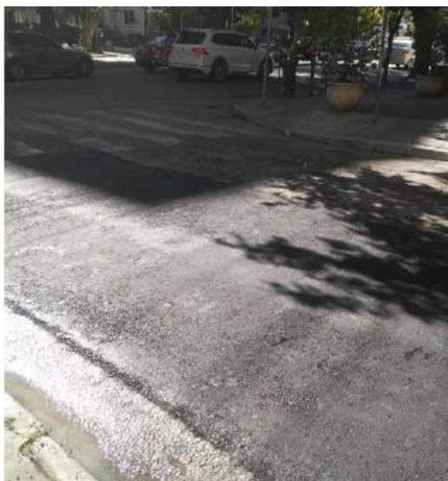
Foto 5 – Caixa após a aplicação da massa e compactação com rolo compactador.
